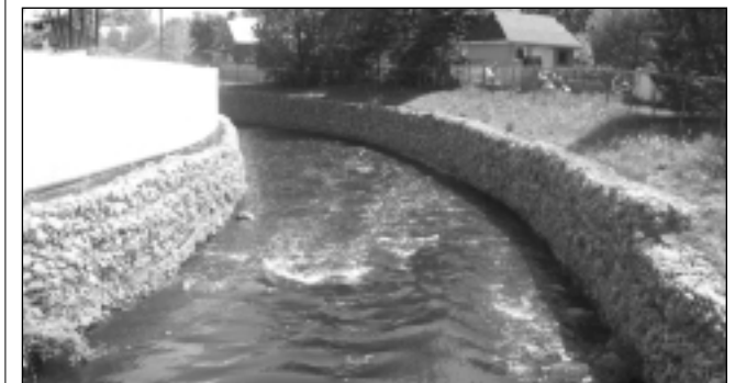
Berges enrochées, rivière Neilson, Loretteville.
